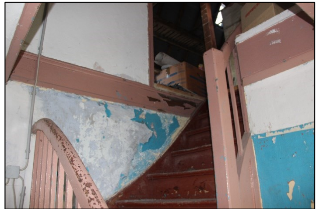
Aufgang zum Dachboden
